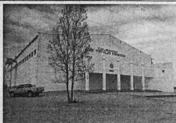
INSTALACIONES DEL GIMNASIO POR FUERA
