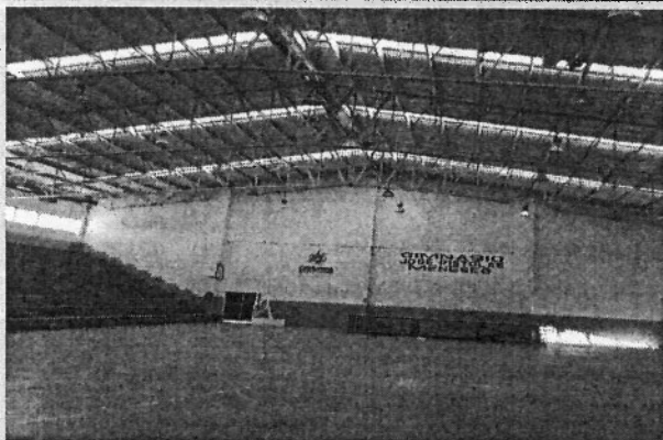
INSTALACIONES DEL GIMNASIO POR DENTRO
