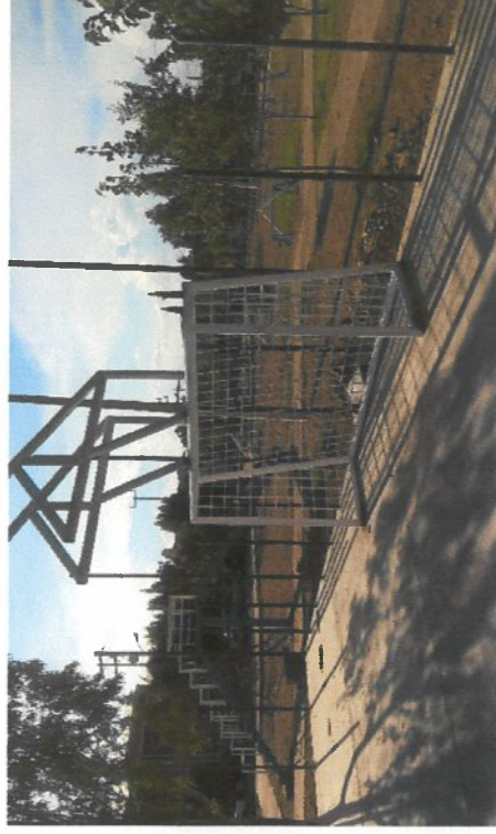
INSTALACION DE PORTERIA EN CANCHA DE USOS MULTIPLES COL. SAN PATRICIO
