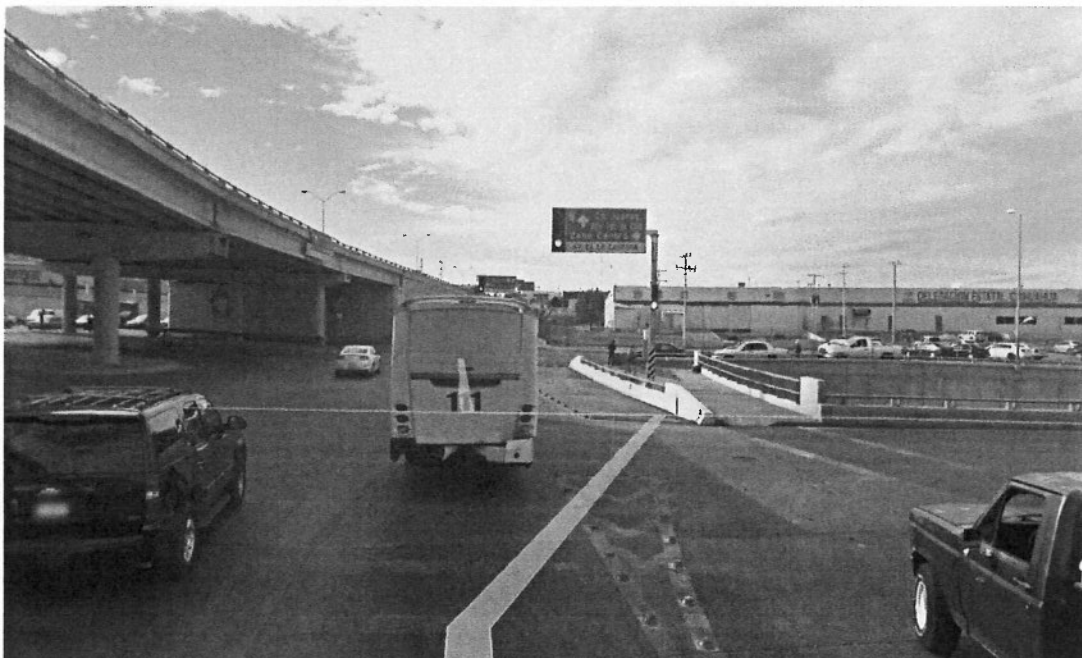
ADECUACIÓN CRUCERO CANTERA
