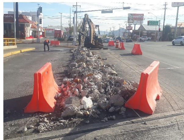
SE REALIZA DEMOLICION DE GUARNICION Y BANQUETA
