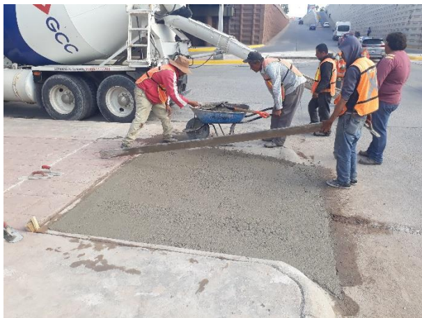
SE COLOCA CONCRETO EN RAMPAS
