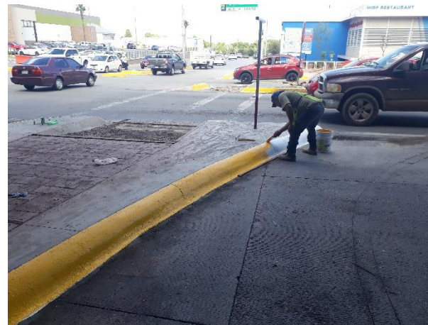
SE MUESTRA APLICACIÓN DE PINTURA EN GUARNICION
