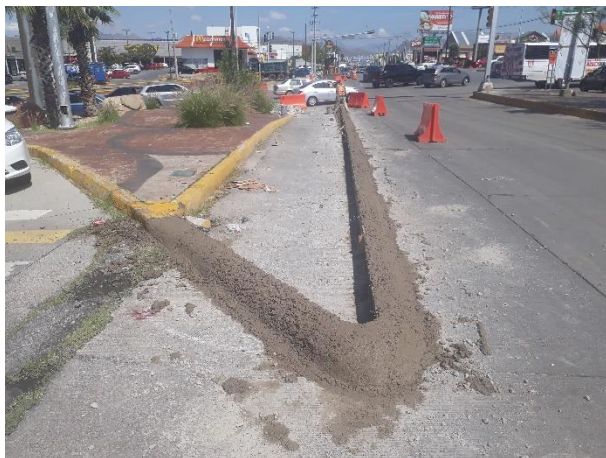
SE MUESTRA COLADO DE GUARNICION
