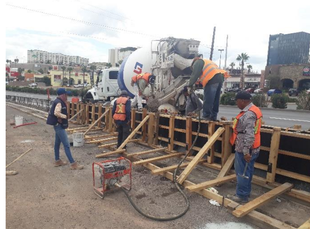
SE MUESTRAN COLADO DE BARRERA CENTRAL
