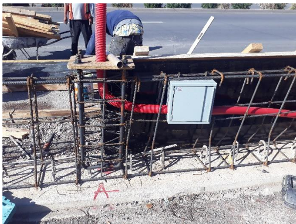
SE MUESTRA COLOCACION Y ARMADO DE BASES DE ALUMBRADO
