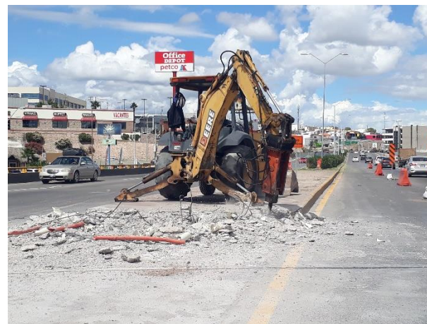
SE MUESTRA DEMOLICION EN CAMELLON DE PERIFERICO DE LA JUVENTUD
