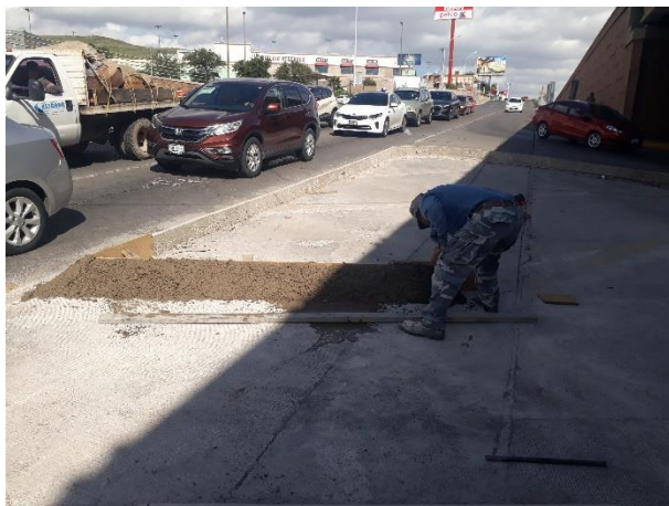
SE MUESTRA COLADO DE GUARNICION
