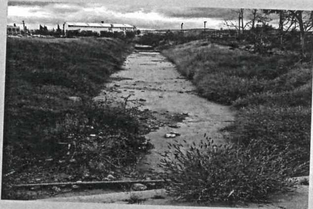
CANAL ARROYO LA GALERA
