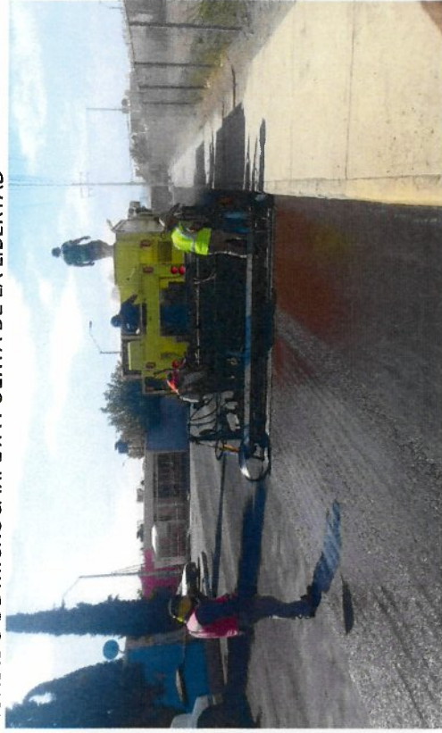
TENDIDO DE MICROCARPETA PUERTA DE LA LIBERTAD
