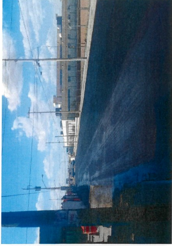
TENDIDO DE MICROCARPETA PUERTA DE LA LIBERTAD
