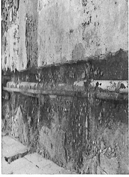
DESMANTELAMIENTO DE TUBERIAS EXISTENTES DE COBRE DE 1" Y PVC DE 2" Y 4"
