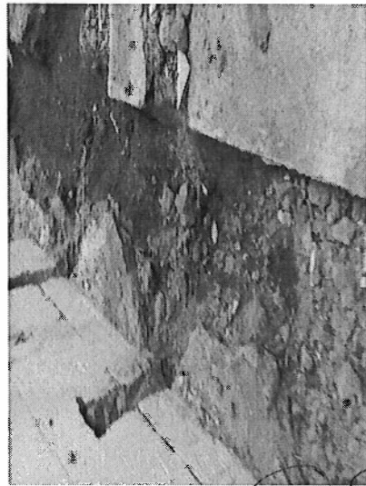
DEMOLICION DE PISO DE CONCRETO
