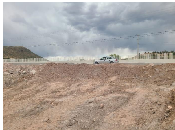
Reparación realizada al costado del pavimento, debidamente arropado y protegido
