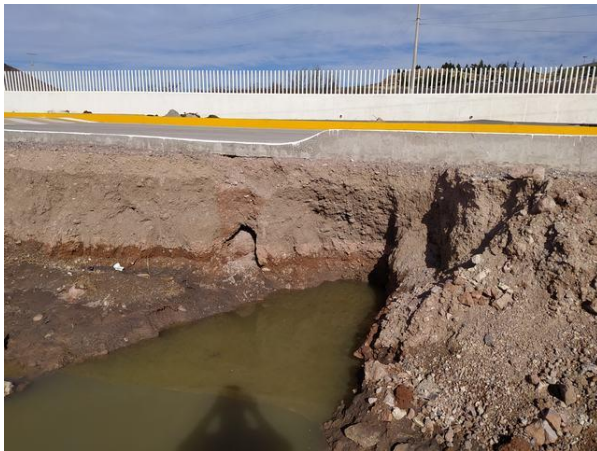
Excavación al costado del pavimento con un talud vertical
