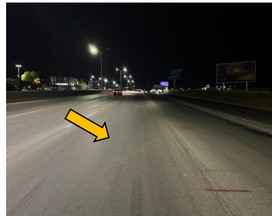
Área de la superficie de rodamiento reparada.
