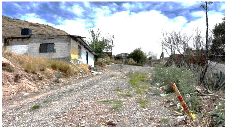
Tratamiento en las terracerías por medio de base hidráulica y riego de impregnación en mal estado en Calle Cerro de la Borrega.
