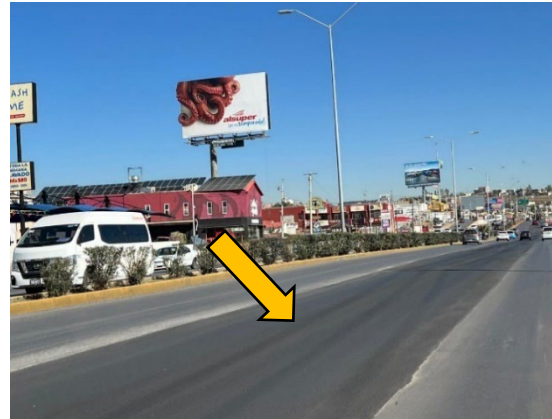
Área de la superficie de rodamiento reparada.
