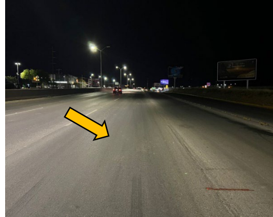
Área de la superficie de rodamiento reparada.
