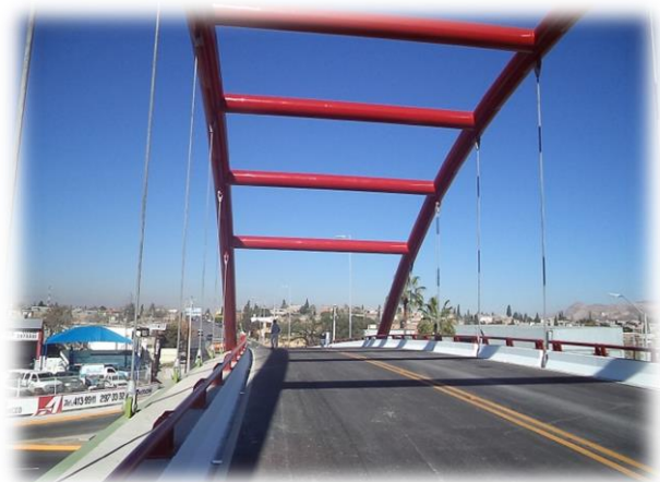
Cuerpo del puente S-N
