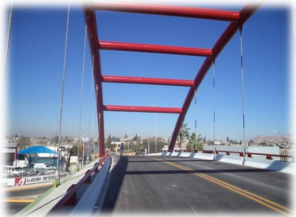
Cuerpo del puente S-N
