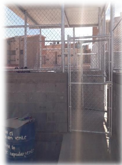
Las puertas ya fueron instaladas.
