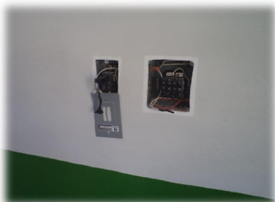
Centros de carga inconclusa Manchas de humedad y testigos de goteras en techos
