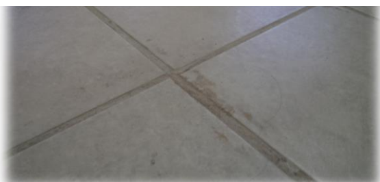
Desnivel en el piso de cerámica más de 3.5 cm en una distancia de 2.0m.
