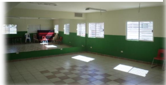
Juntas del piso desalineadas
