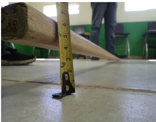
Desnivel en el piso de cerámica más de 3.5 cm en una distancia de 2.0m.
