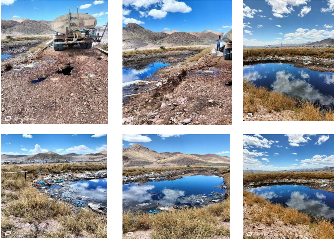
Imagen 2.18. Descarga de Lixiviados
