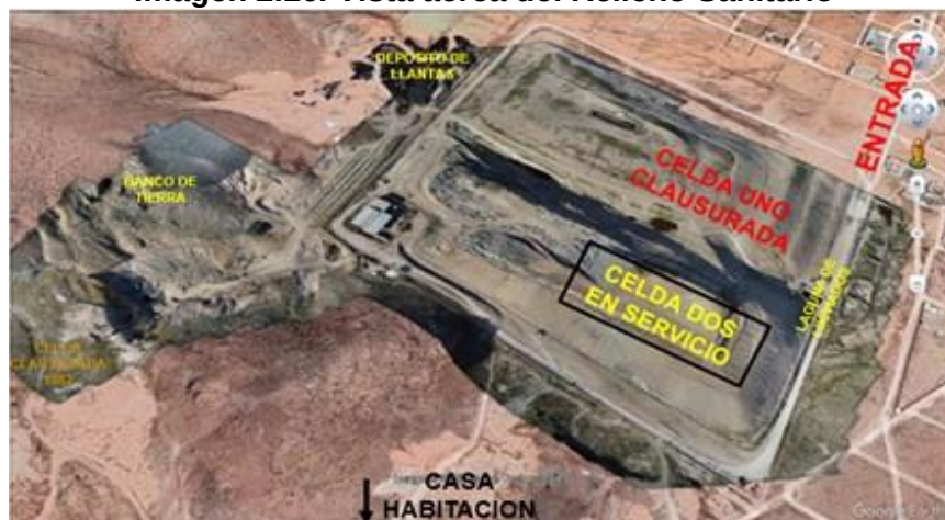
Imagen 2.16. Vista aérea del Relleno Sanitario
