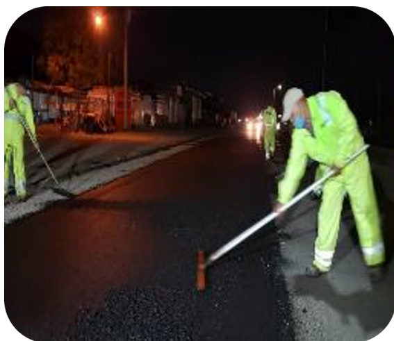
REHABILITACIÓN DE PAVIMENTO EN AVENIDA SILVESTRE TERRAZAS
