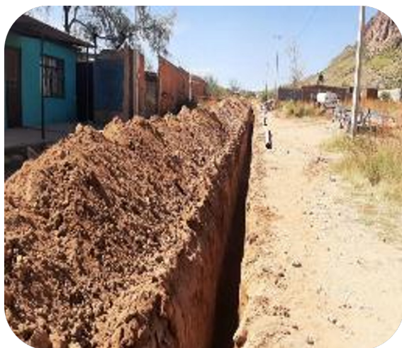
CONSTRUCCIÓN DE ALCANTARILLADO SANITARIO (III ETAPA) EN COL. LAS NORIAS
