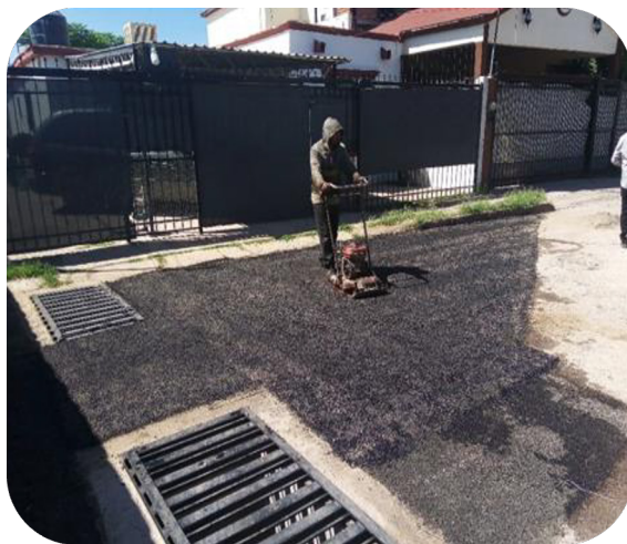
CANALIZACIÓN Y DREN PARA DESAGUE PLUVIAL EN CALLE DE LOS PINOS
