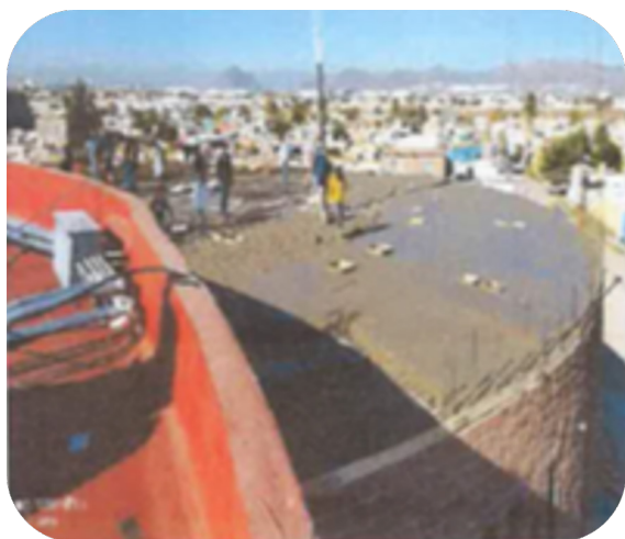
CONSTRUCCIÓN DE CENTRO DE DESARROLLO FAMILIAR ETAPA 2 Y 3
