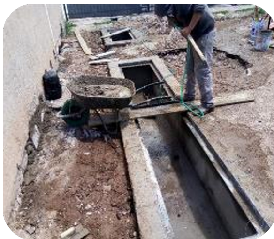
CANALIZACIÓN Y DREN PARA DESAGUE PLUVIAL EN CALLE DE LOS PINOS
