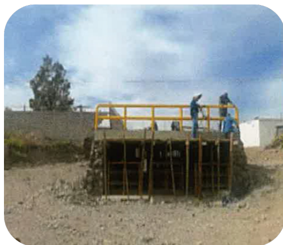
CONSTRUCCIÓN DE PUENTE VEHICULAR SOBRE ARROYO ARCOS I
