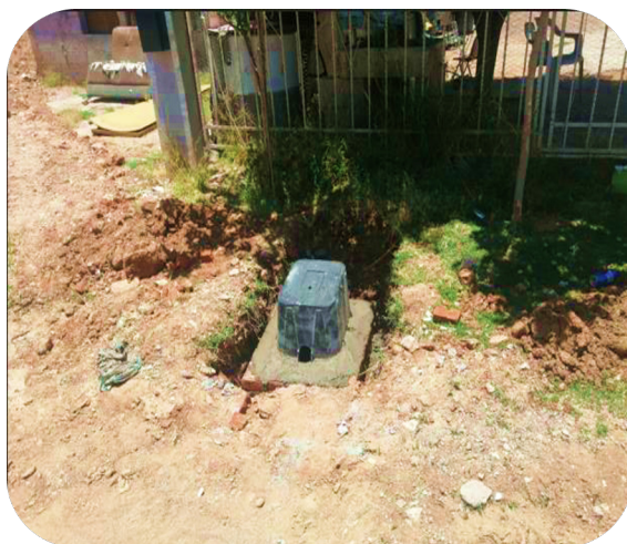
CANALIZACIÓN Y DREN PARA DESAGUE PLUVIAL EN CALLE DE LOS PINOS
