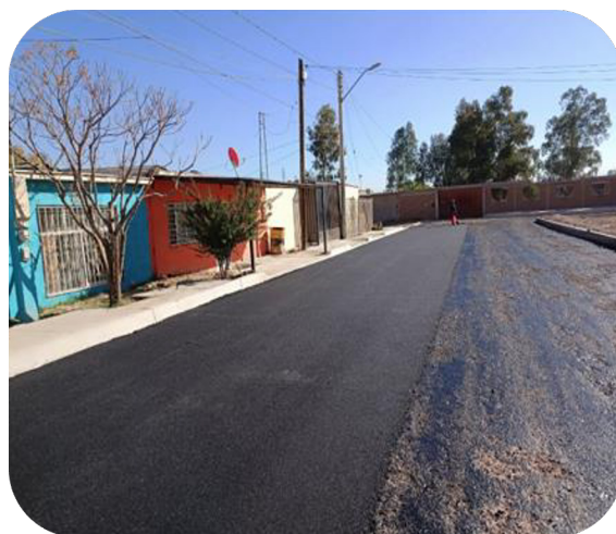
PAVIMENTACIÓN EN CALLE 7A DE LA COLONIA GRANJAS DEL CERRO GRANDE
