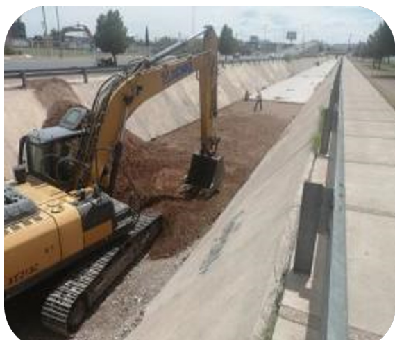
RECONSTRUCCIÓN DE LOSAS DE CONCRETO ARMADO
