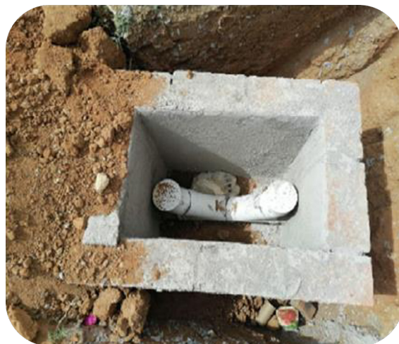
CONSTRUCCIÓN DE ALCANTARILLADO SANITARIO (II ETAPA) EN COL. LAS NORIAS
