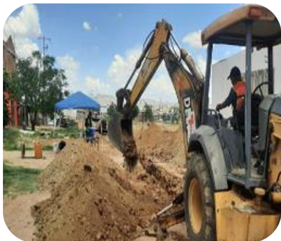
CONSTRUCCIÓN DE ALCANTARILLADO SANITARIO (I ETAPA) EN COL. LAS NORIAS
