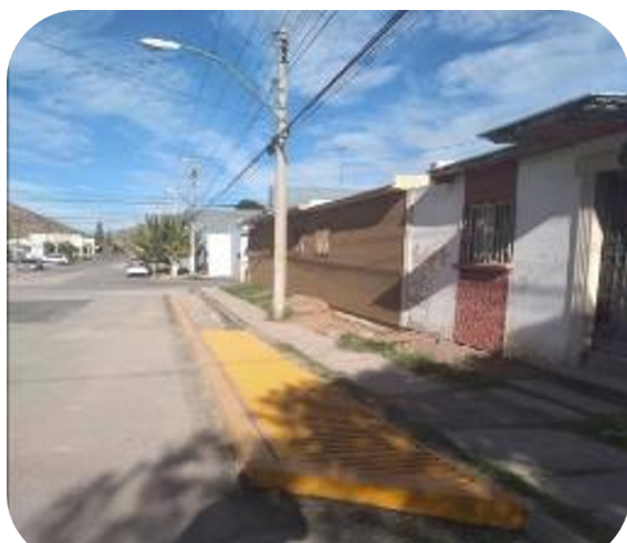
REHABILITACIÓN DE DREN PLUVIAL EN CALLE 45 Y C. MANUEL OJINAGA
