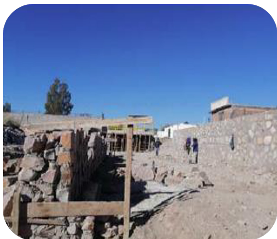
CONSTRUCCIÓN DE CANALIZACIÓN DE ARROYO ARCOS I
