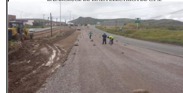
NIVELACION DE CAPA DE BASE
