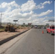
EN AMPLIACIÓN DE CARRETERA 0+000 A 0+170
