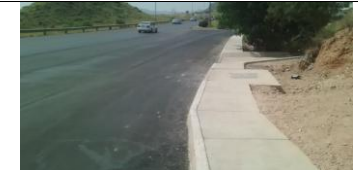
TRAMO DEL KM 0+140.00 AL 0+180.00
