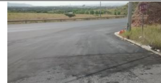
INICIO DEL TRAMO DEL KM 0+190
