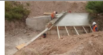
COLADO DE LOSA EN OBRA DEL KM 0+450.00
