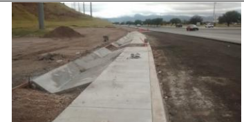
GUARNICION, BANQUETA Y CUNETA DEL KM 1+300 AL 1+400
