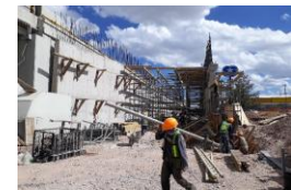
COLOCACION DE CIMBRA EN GAZA SMART
