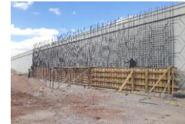
COLOCACION DE CIMBRA EN GAZA SORIANA
