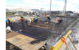
COLOCACION DE ACERO EN LOSA EN GAZA FORD
