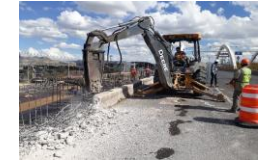
DEMOLICION DE PARAPETO EN GAZA FORD
