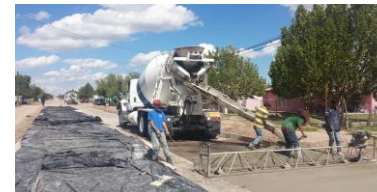
COLADO DE CARPETA HIDRAULICA
