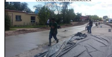
COLADO DE CARPETA HIDRAULICA
