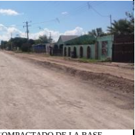
OMPACTADO DE LA BASE
