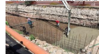
COLADO DE LOSA INFERIOR (PISO) DEL KM 2+685.00 AL 2+700.00
