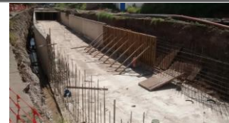
ARROPE Y CIMBRA DE MURO SUR DEL KM 2+680.00 AL 2+700
