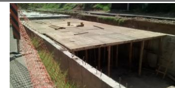
CIMBRA DE LOSA SUPERIOR DEL KM 2+760.00 AL 2+780.00
