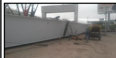
CONEXIÓN EN CAMPO DE VIGA 1 TRAMO 2-3.
