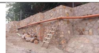
MURO DE MAMPOSTERIA Y TUBO DE DRENAJE
