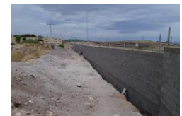
SE MUESTRA BARDA TERMINADA
