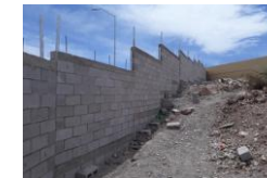
SE MUESTRA BARDA TERMINADA
