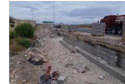
SE REALIZA COLADO DE DALA DE CERRAMIENTO
