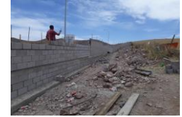
SE REALIZA COLCACION DE BLOCK
