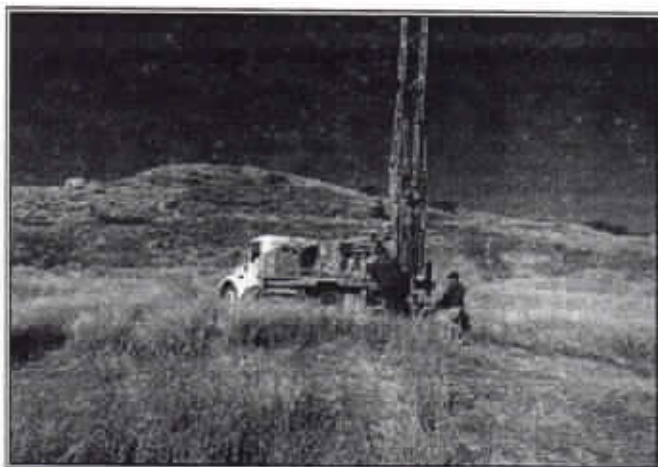
PERFORADORA COLOCADA EN EL PUNTO DEL SONDEO SP-1
