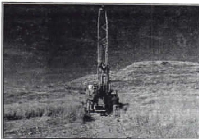
PERFORADORA COLOCADA EN EL PUNTO DEL SONDEO SP-2
