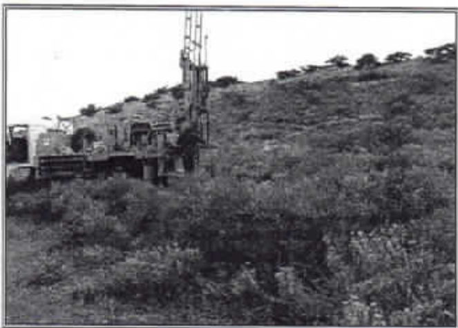
PERFORADORA COLOCADA EN EL PUNTO DEL SONDEO SP-9, CERCANO A LA ESQUINA NORESTE DEL PREDIO
