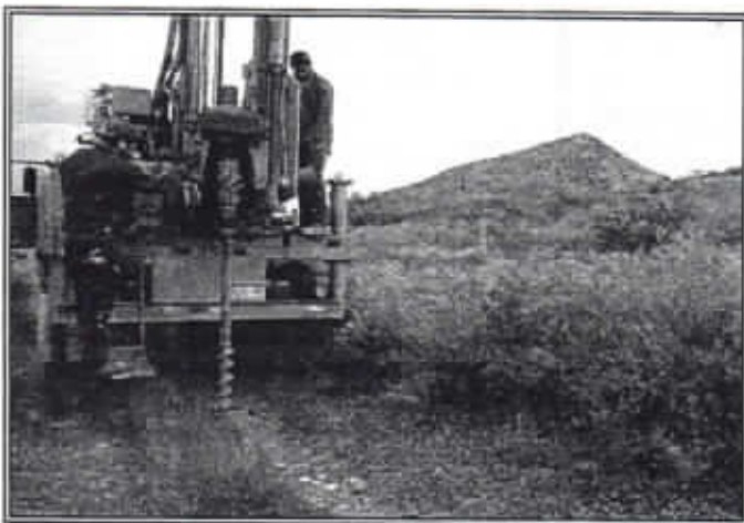
PERFORADORA COLOCADA EN EL PUNTO DEL SONDEO SP-10, EN EL COSTADO ORIENTAL DEL PREDIO
