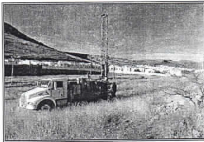
PERFORADORA COLOCADA EN EL PUNTO DEL SONDEO SP-6
