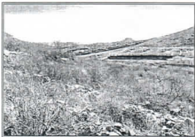
VISTA DESDE LA PARTE ALTA HACIA EL SUR DEL PREDIO
