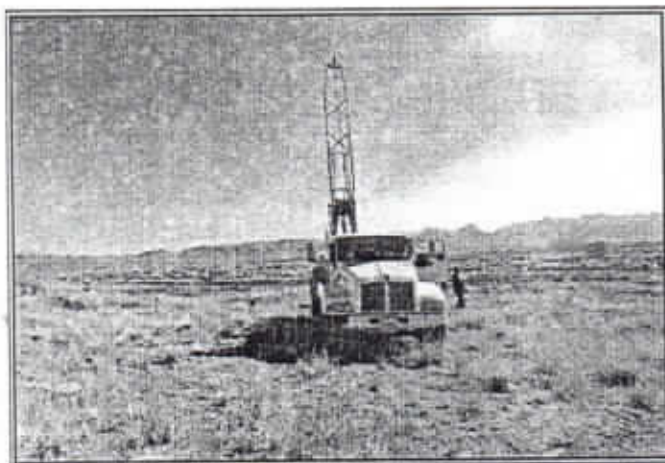
PERFORADORA COLOCADA EN EL PUNTO DEL SONDEO SP-5
