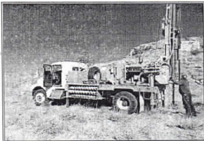
PERFORADORA COLOCADA EN EL PUNTO DEL SONDEO SP-3
