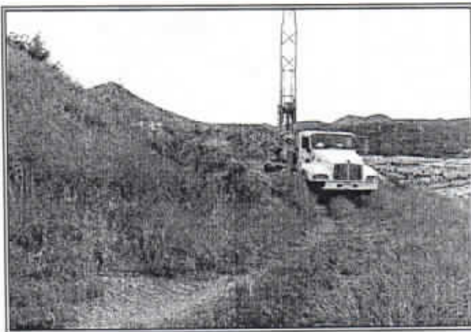
PERFORADORA COLOCADA EN EL PUNTO DEL SONDEO SP-8, AL NORTE DE LA PARTE ALTA DEL PREDIO
