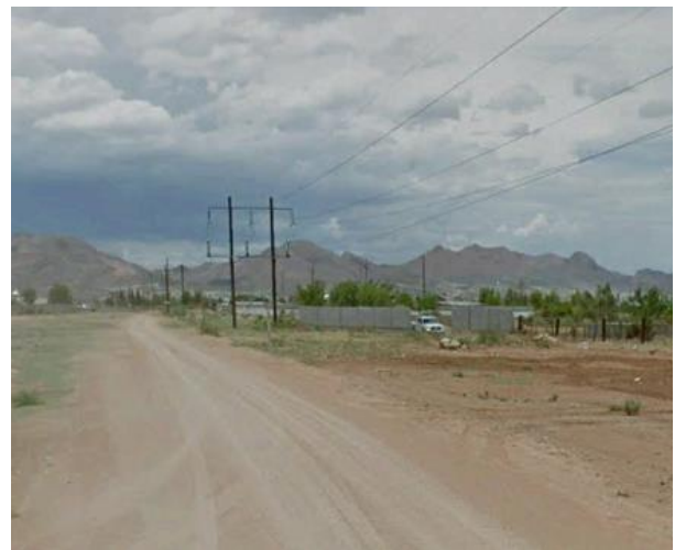
LINEA DE ALTA TENSION CALLE SIERRA EL PUMA
