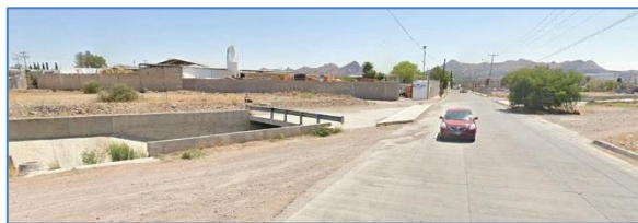
Imagen 37. Infraestructura pluvial existente de paso a desnivel vehicular Arroyo Concordia. Fuente; Google earth.
