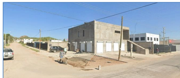
Imagen 6. BODEGAS Y OFICINAS. Fotografía Google Earth.
