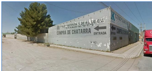
Imagen 14. ACOPIO DE CHATARRA. Fotografía Google Earth
