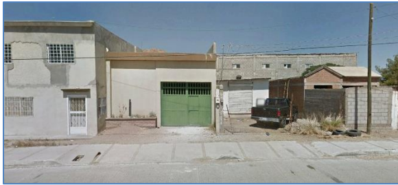
Imagen 12. Bodegas. Fotografía Google Earth
