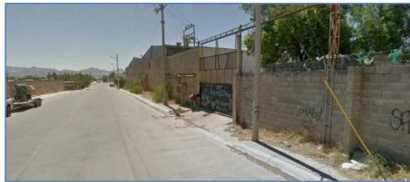
Imagen 3. BODEGAS Y TALLERES VARIOS. Fotografía Google Earth
