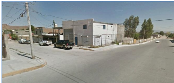
Imagen 13. Bodegas y OFICINAS. Fotografía Google Earth
