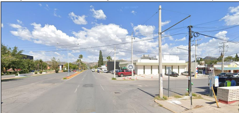
Imagen 44. Infraestructura de energía eléctrica en la calle Antonio Deza y Ulloa.
