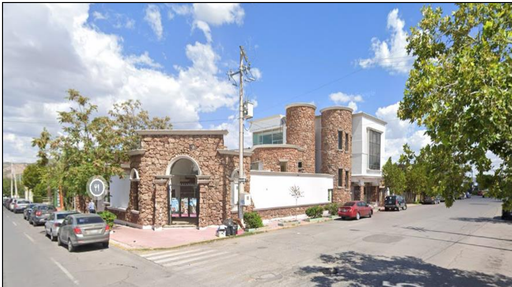
Imagen 79. Vista de infraestructura cercana al predio de estudio.
