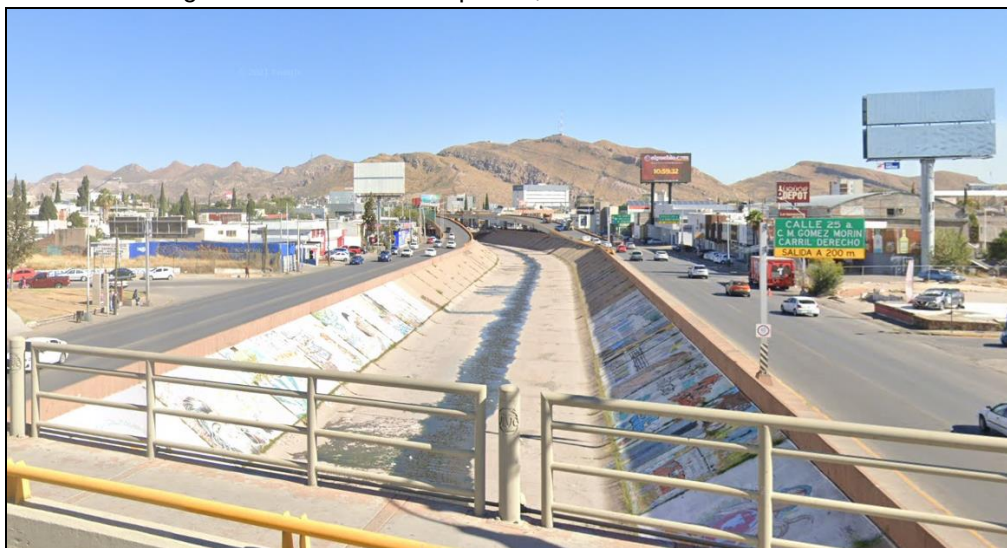
Imagen 50. Infraestructura pluvial, canalización. Río Chuviscar.
