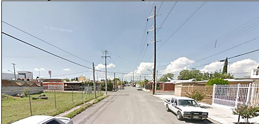
Imagen 43. Infraestructura de energía eléctrica en calle Cedro.
