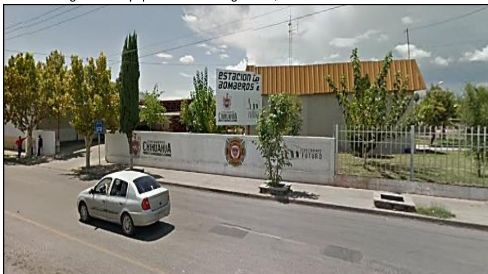
Imagen 29. Equipamiento de seguridad, Estación de Bomberos No. 2.
