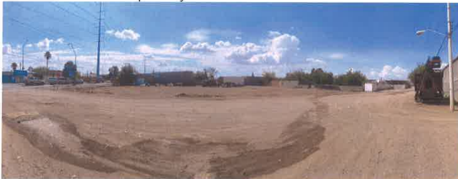
Predio en proceso de limpieza
