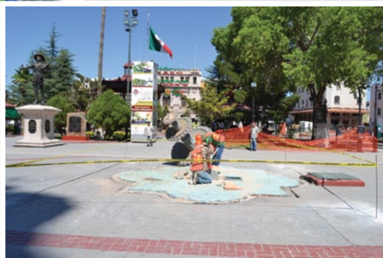
Trabajos Plaza de Armas
