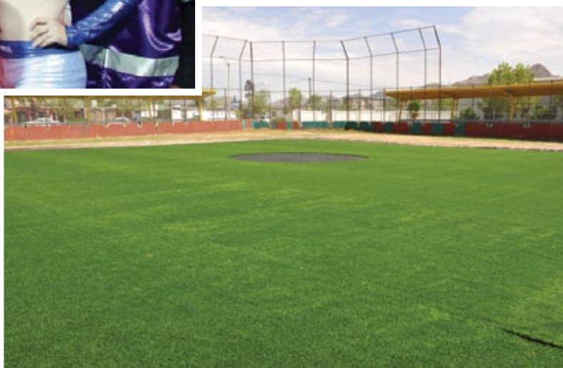
Rehabilitación de Parque de Beisbol Nuevo Milenio
