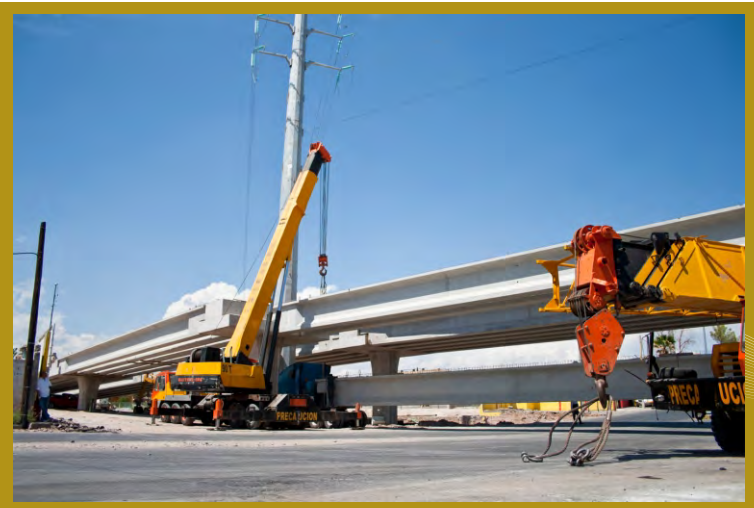
Construcción de 3 Nuevos Pasos a Desnivel.
