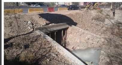
PANORAMICA DE OBRA DE DRENAJE
