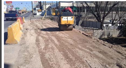
COMPACTACION EN RELLENOS
