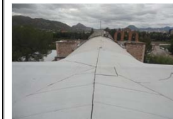
VISTA DE LA IMPERMEABILIZACIÓN DESDE AZOTEA
