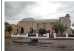
VISTA EXTERIOR DEL TEMPLO
