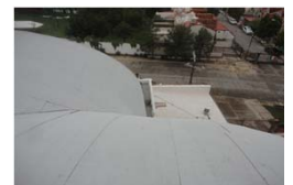
RENIVELACIÓN DE CANAL PLUVIAL
