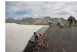
INSTALACIÓN DE 2A CAPA DE IMPERMEABILIZACIÓN
