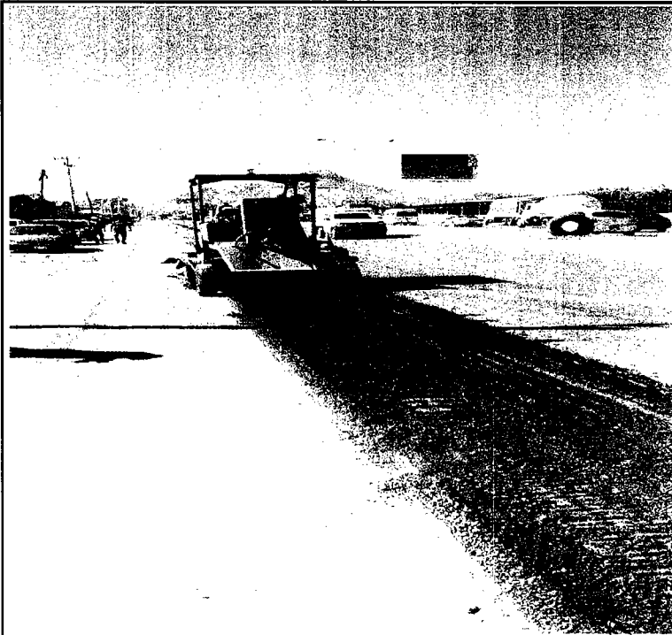
ACTIVIDAD BARRIDO PRODUCTO DE FRESADO EN TRAMO 2
