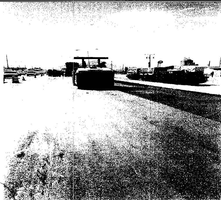
ACTIVIDAD TENDIDO DE SOBRECARPETA TODO LO ANCHO EN TRAMO 3
