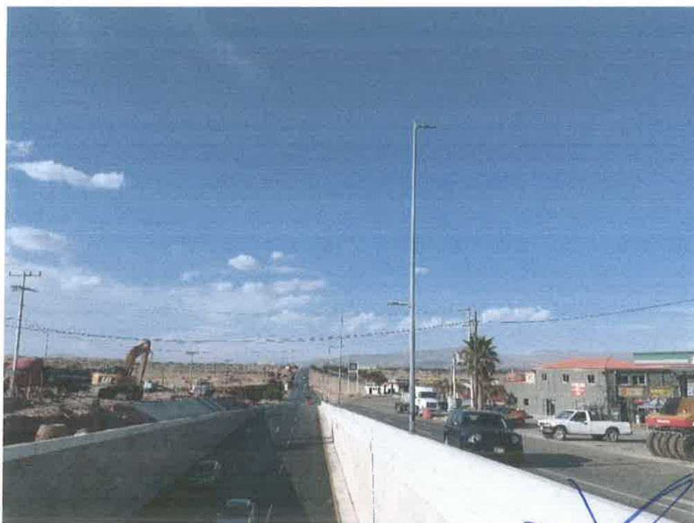
POSTES DE ALUMBRADO
