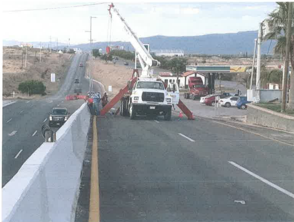
COLOCACION DE POSTES DE ALUMBRADO
