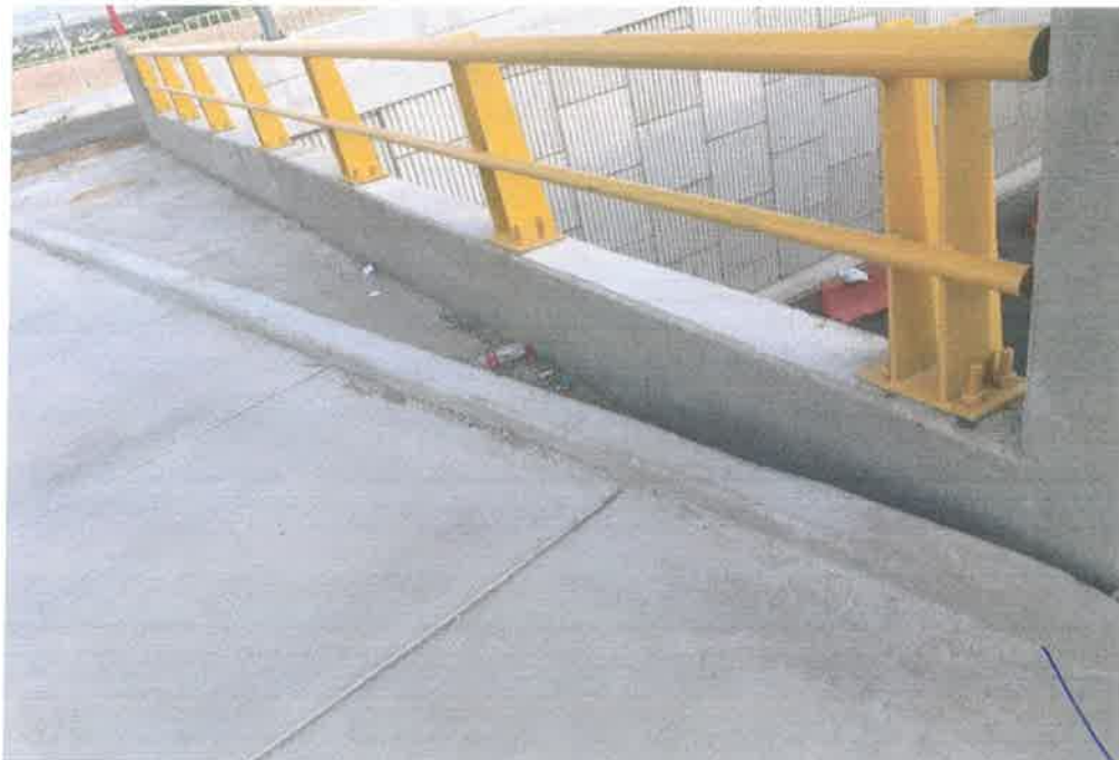
PARAPETO DE PUENTE
