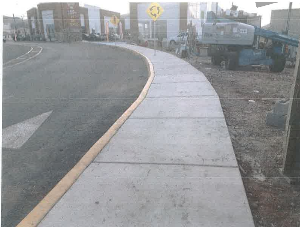
BANQUETAS DE 8 CM
