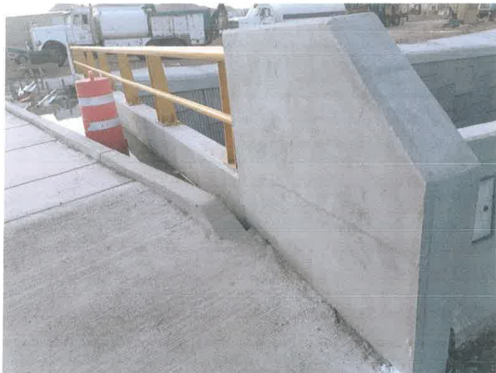
REMATE DE PARAPETO EN PUENTE
