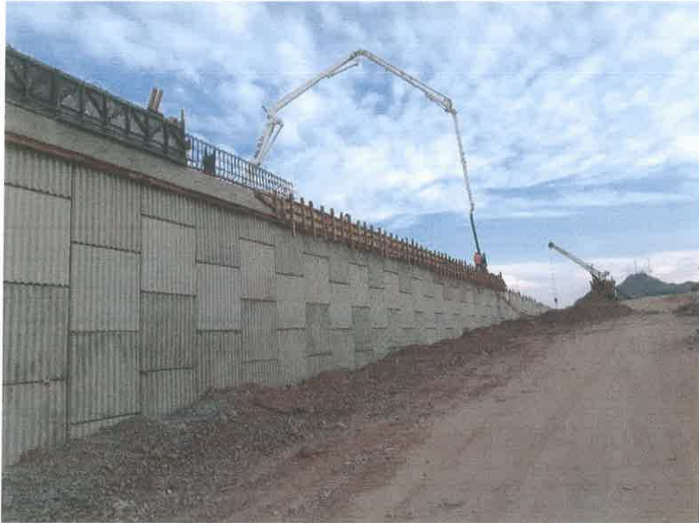
COLADO DE REMATE DE MURO
