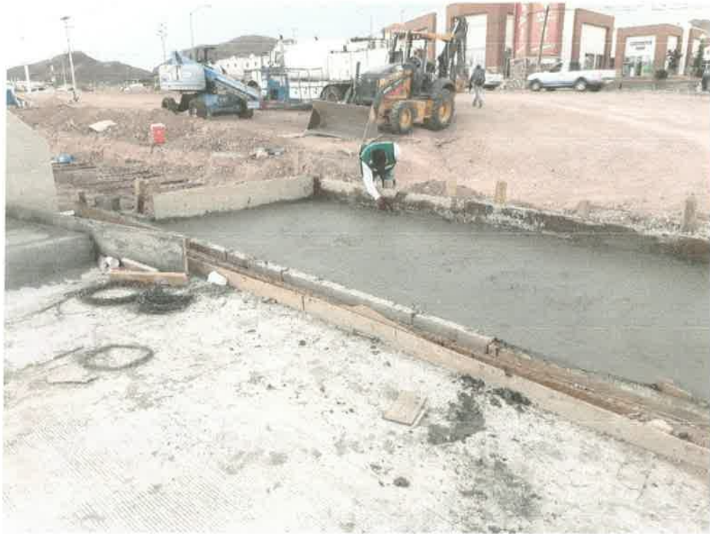
COLADO DE LOZAS DE ACCESO
