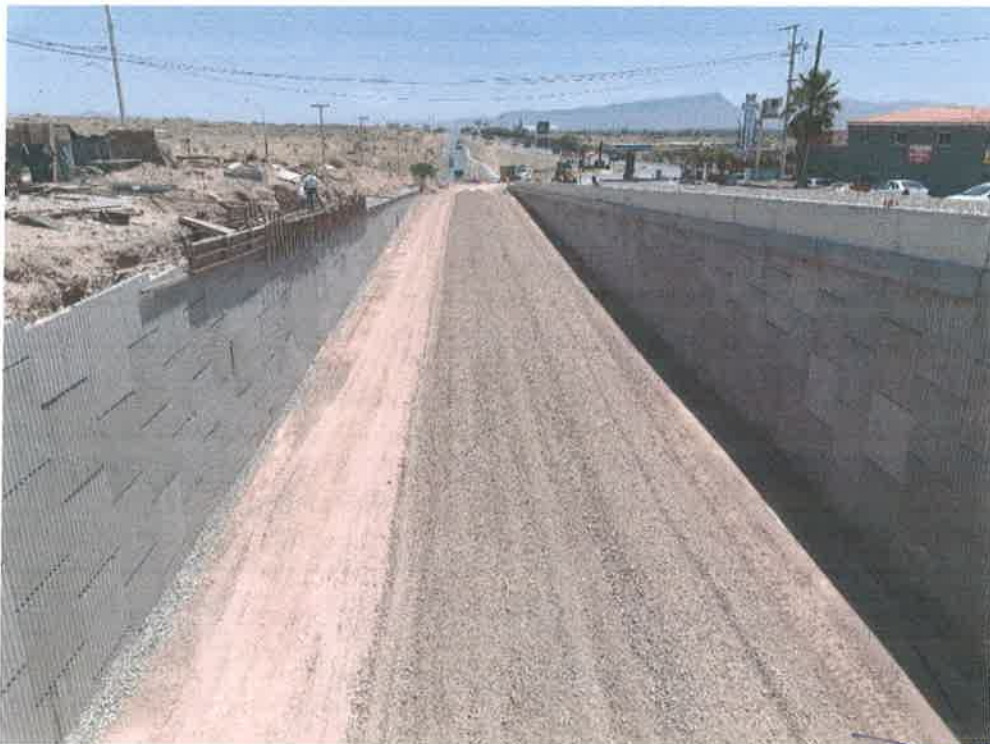
COLADO DE REMATE DE MURO
