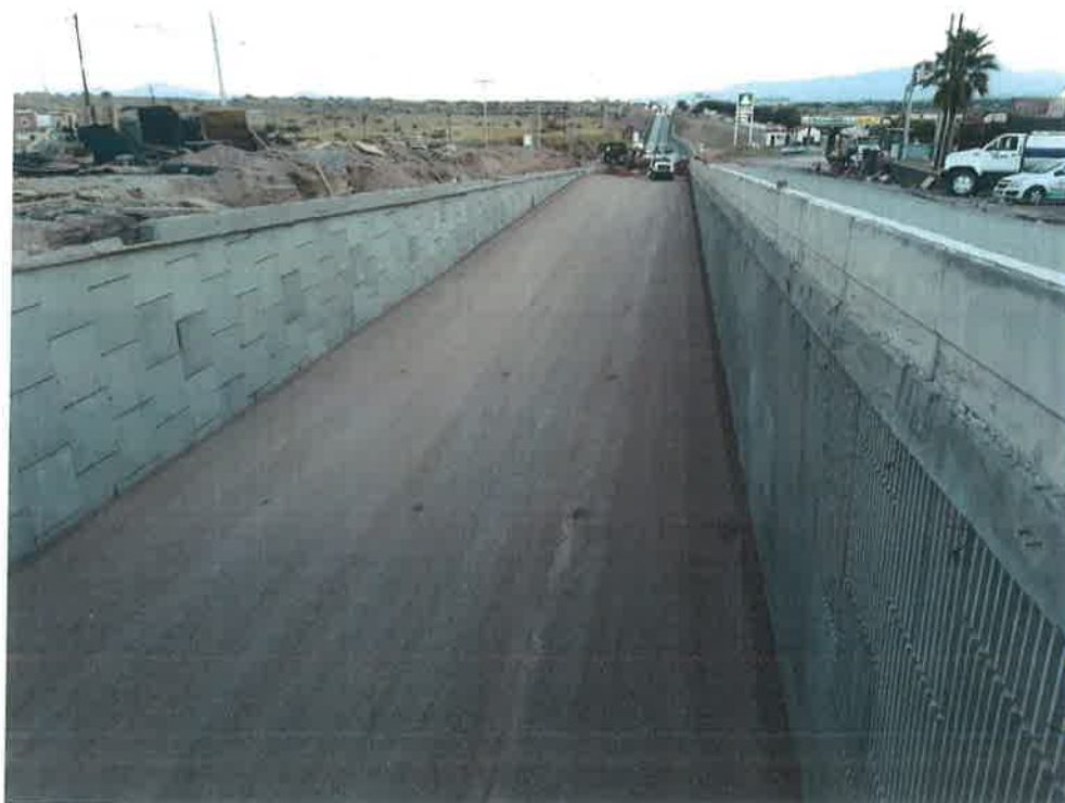
TRATAMIENTO DE MATERIAL DE BASE
