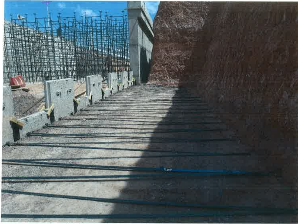
TRABAJOS DE TIERRA ARMADA
