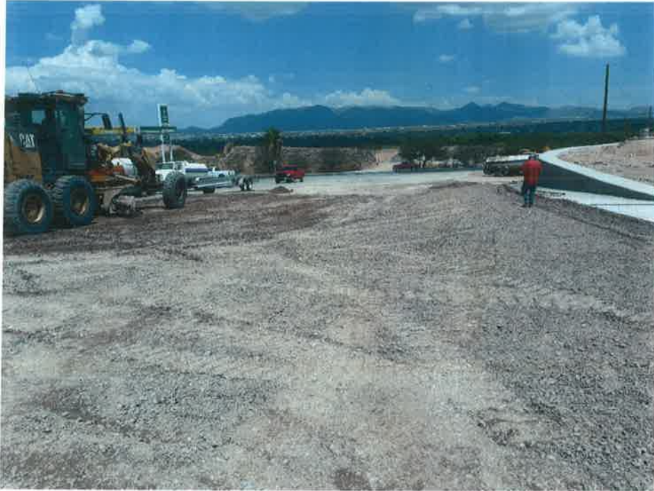
TENDIDO Y TRATAMIENTO DE MATERIAL DE BASE
