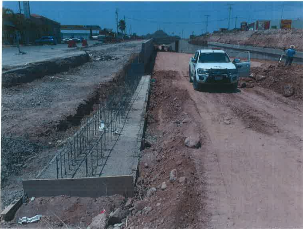
NIVELACION DE LA CAPA DE SUBRASANTE
