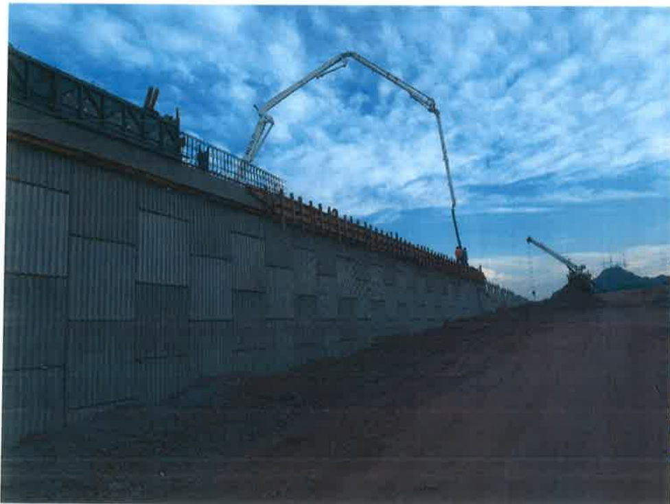
COLADO DE REMATE DE MURO
