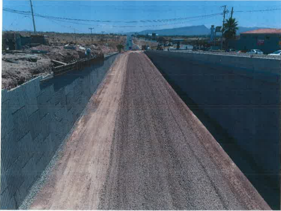
COLADO DE REMATE DE MURO
