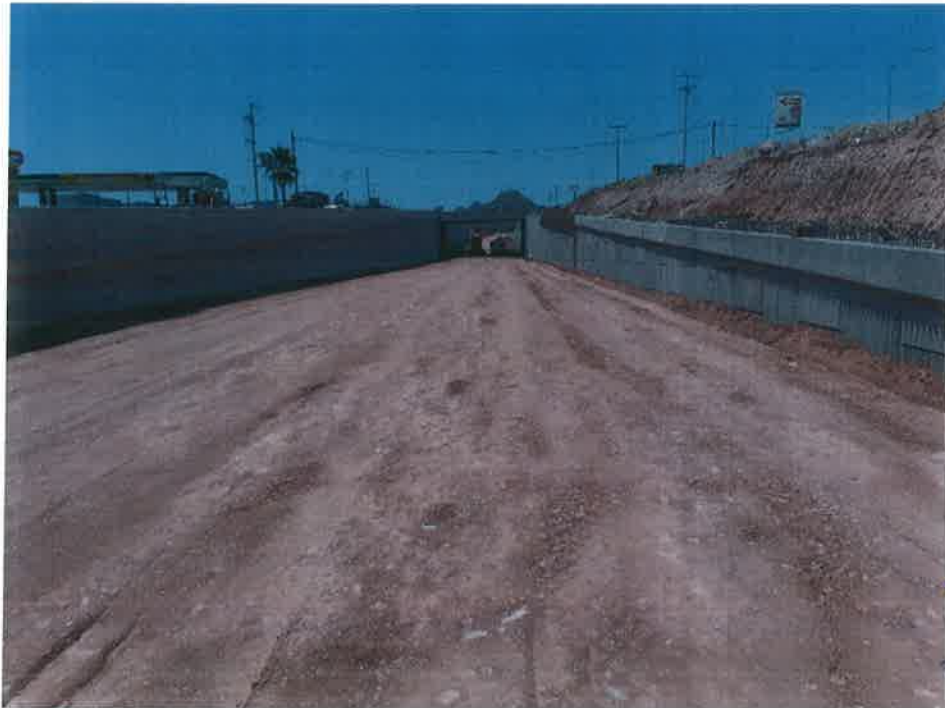
TENDIDO Y TRATAMIENTO DE LA CAPA DE SUBRASANTE
