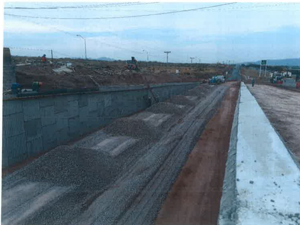
TRATAMIENTO DE MATERIAL DE SUBBASE
