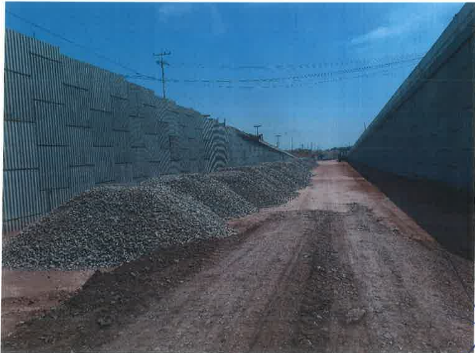
TIRO DE MATERIAL PARA SUBBASE
