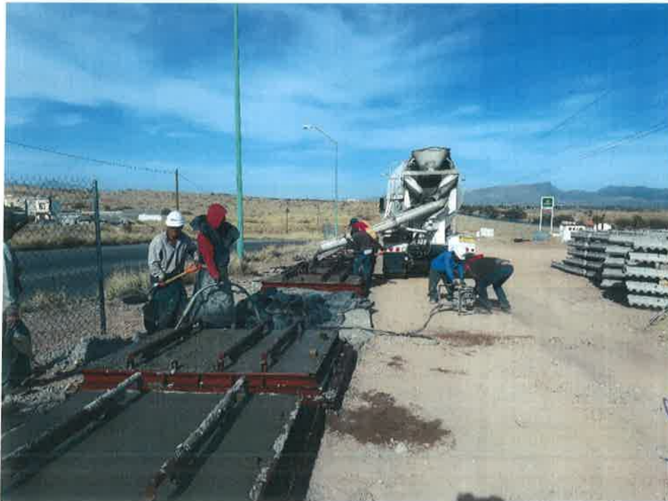
COLADO DE PIEZAS PARA MURO DE TIERRA ARMADA
