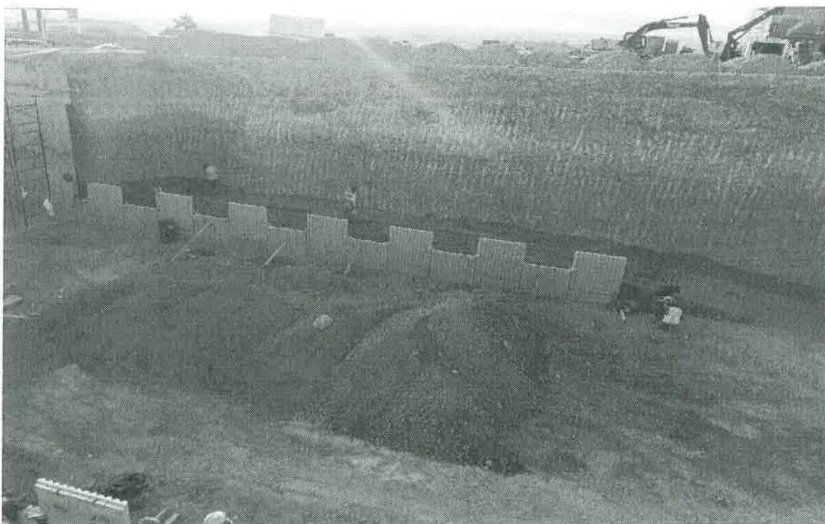
Colocación de Escamas
