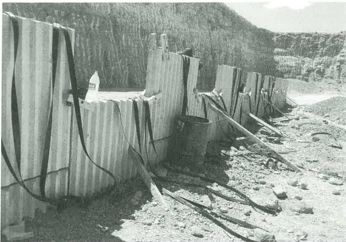
Colocación de Escamas
