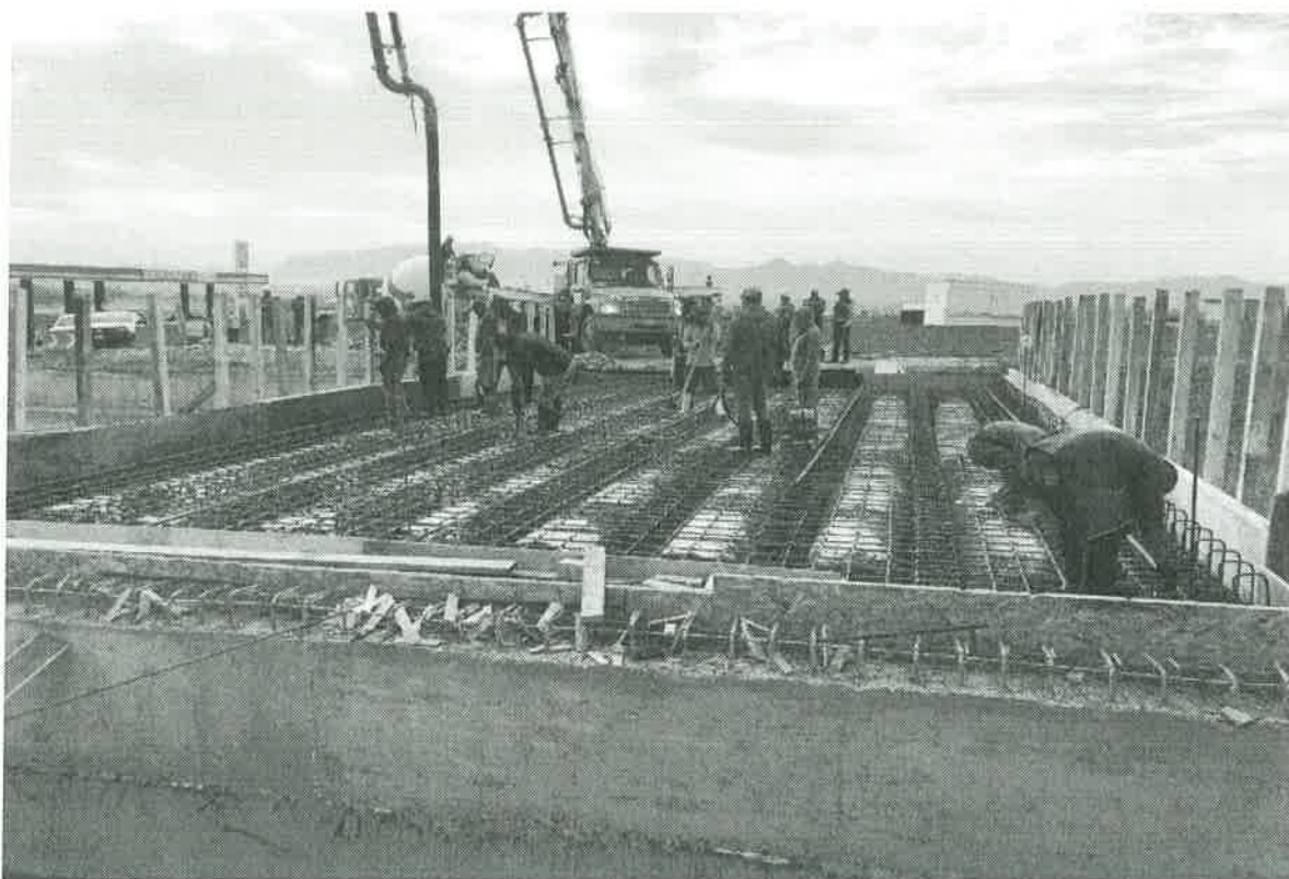
Concreto en Losas
