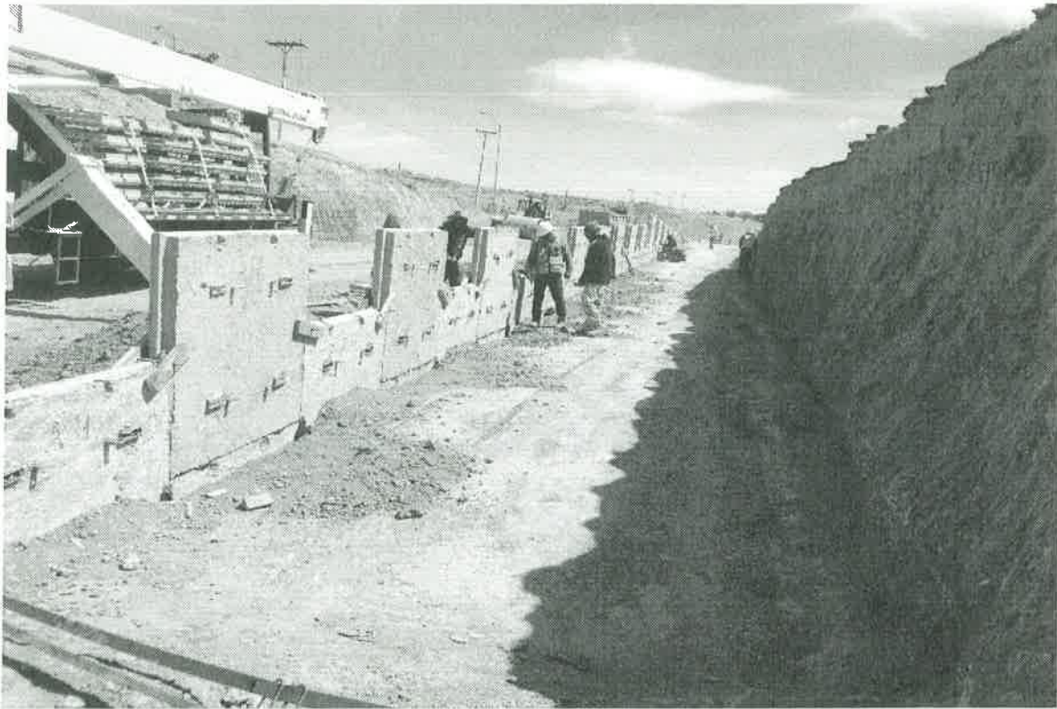
Colocación de escamas
