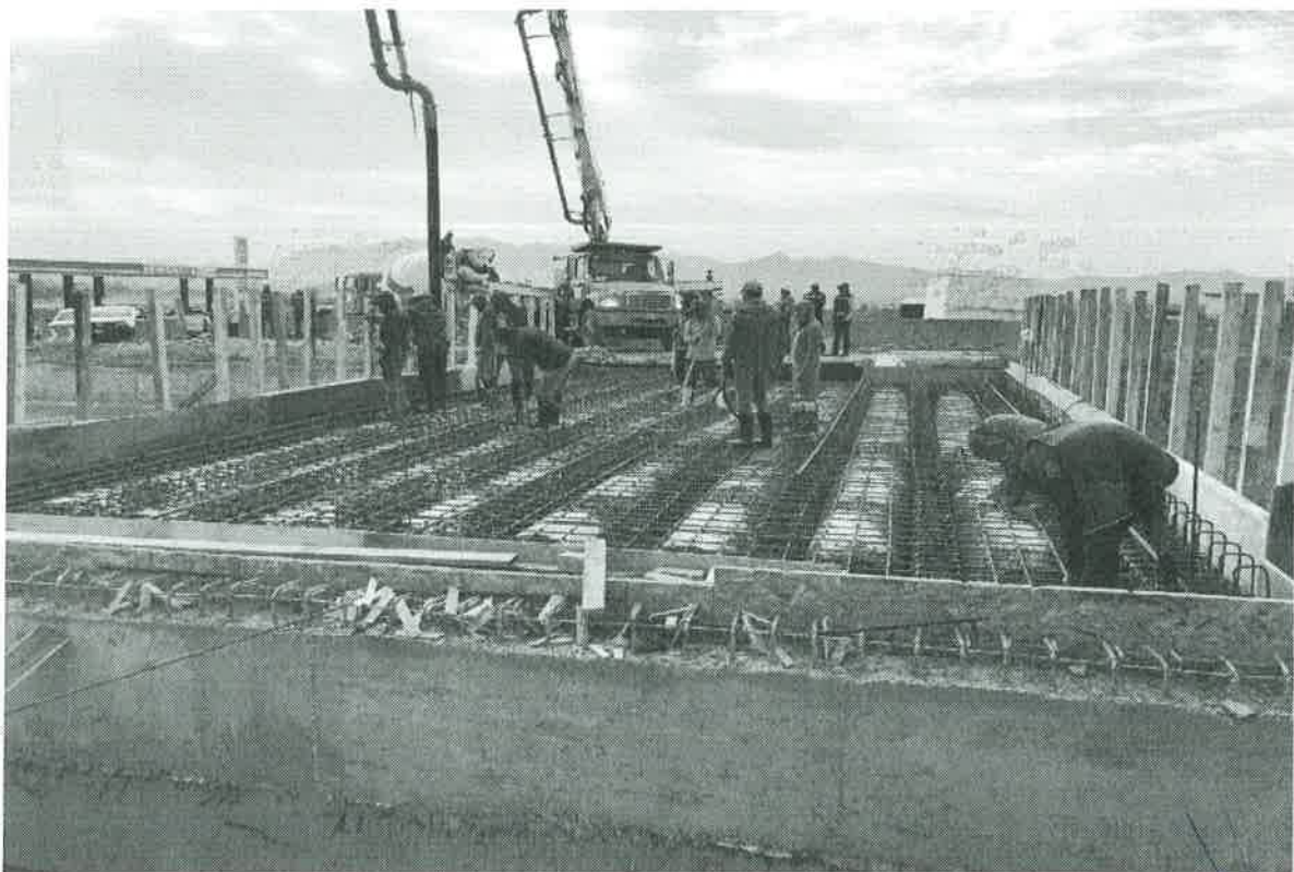
Acero en Losa
