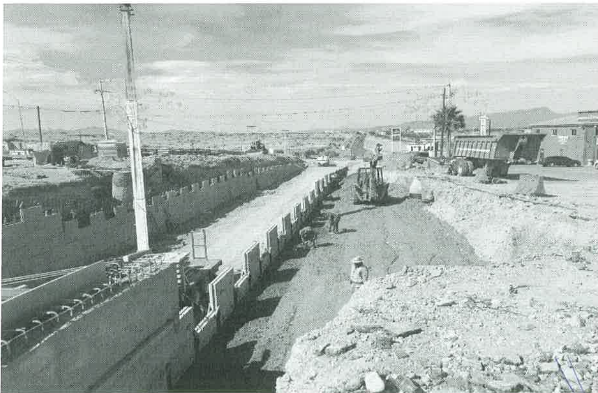
Colocación de Escamas
