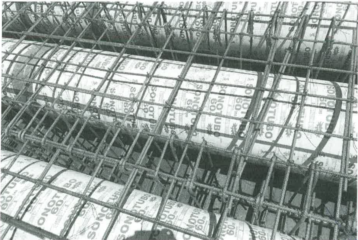
Acero en Losa
