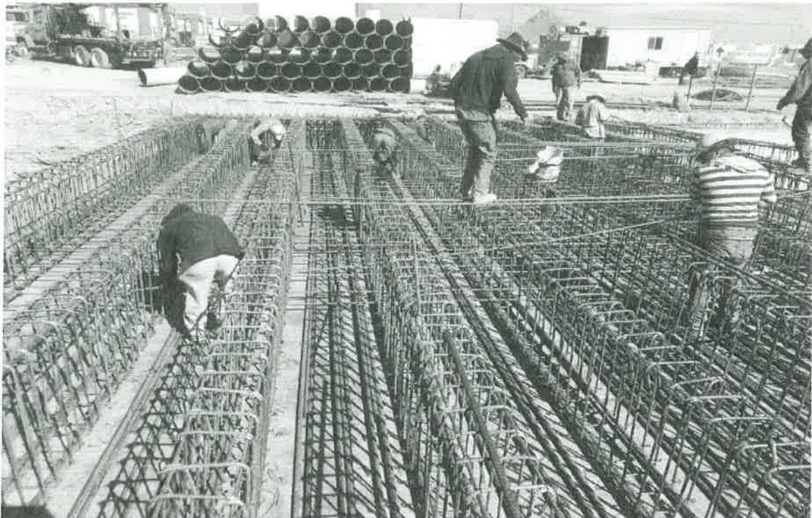
Acero en Losa
