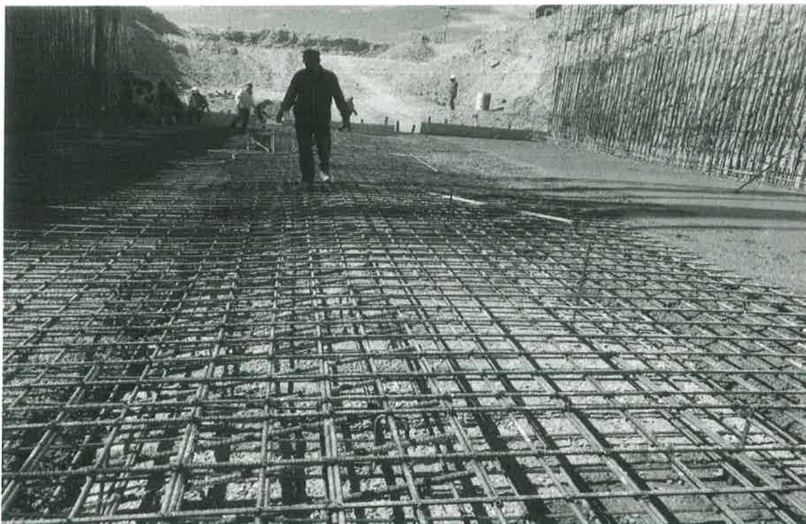
Colocación de acero
