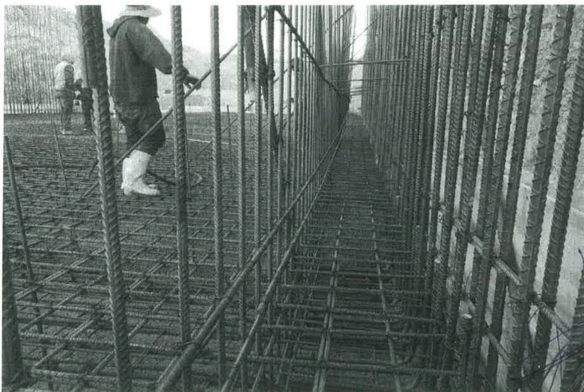
Colocación de Acero
