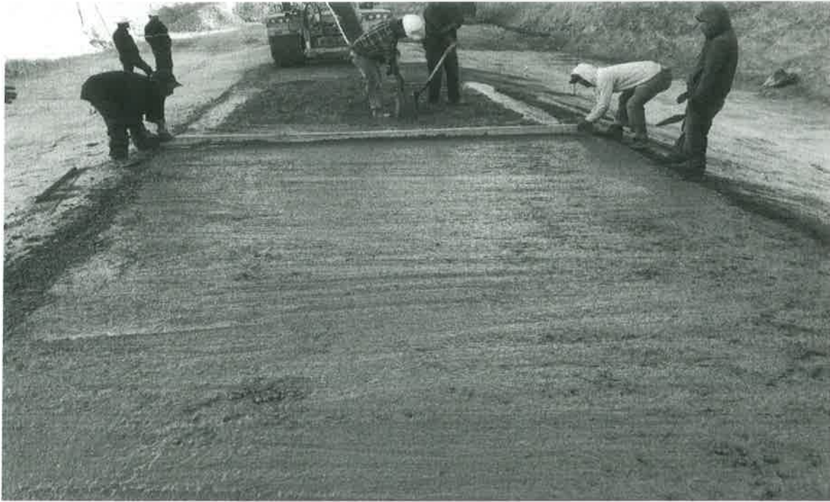
Concreto en Plantilla
