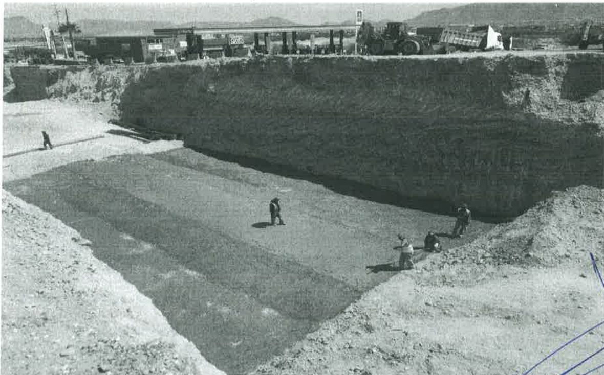
Concreto en Plantilla
