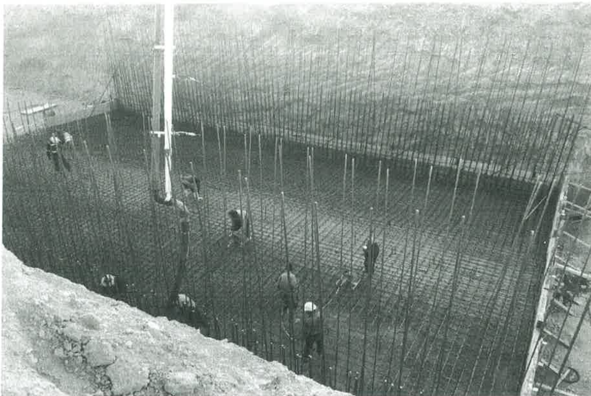
Concreto en Zapata
