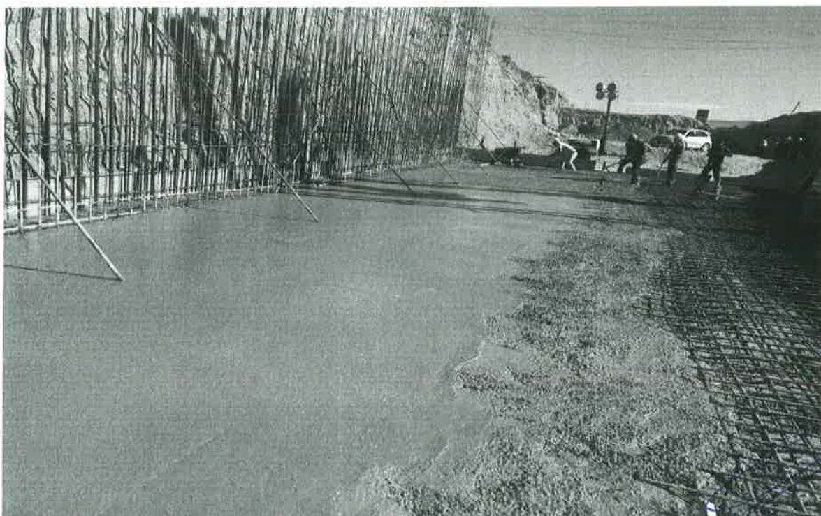
Concreto en Zapata
