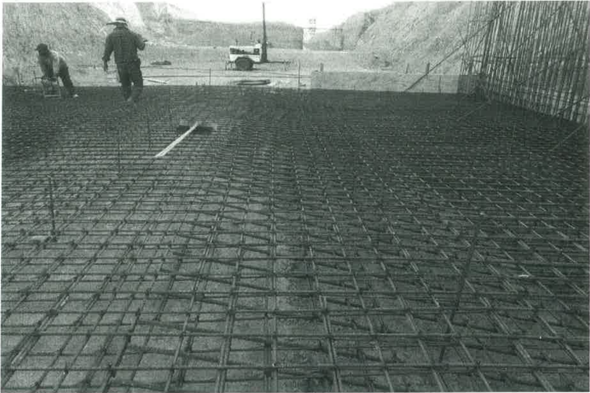
Colocación de Acero
