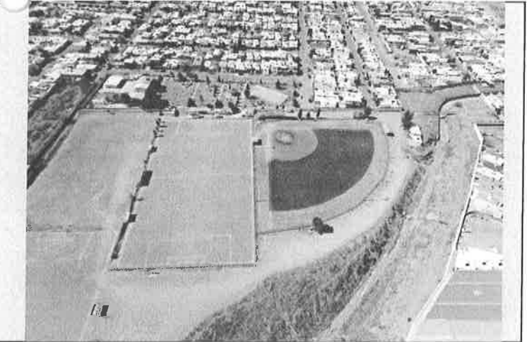
VISTA AEREA DESDE LA AV. DE LAS INDUSTRIAS
