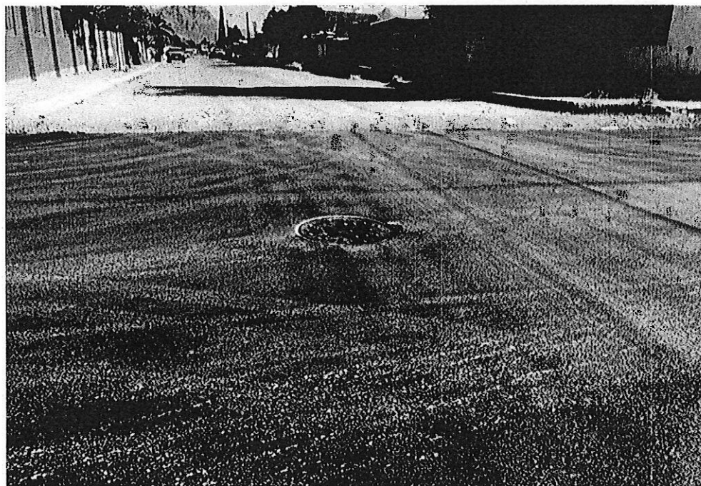
POZOS DE VISITA
