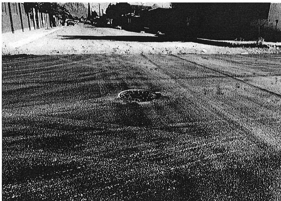
POZOS DE VISITA
