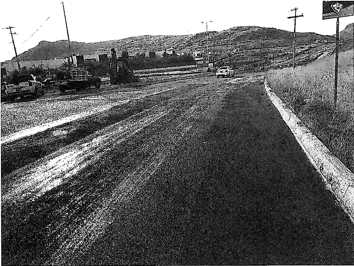
CONCRETO ASFALTICO EMPLEADO EN RENIVELACIONES
