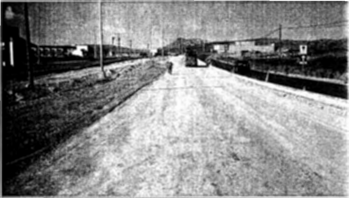
CAPA DE SUBRASANTE COMPACTADA
