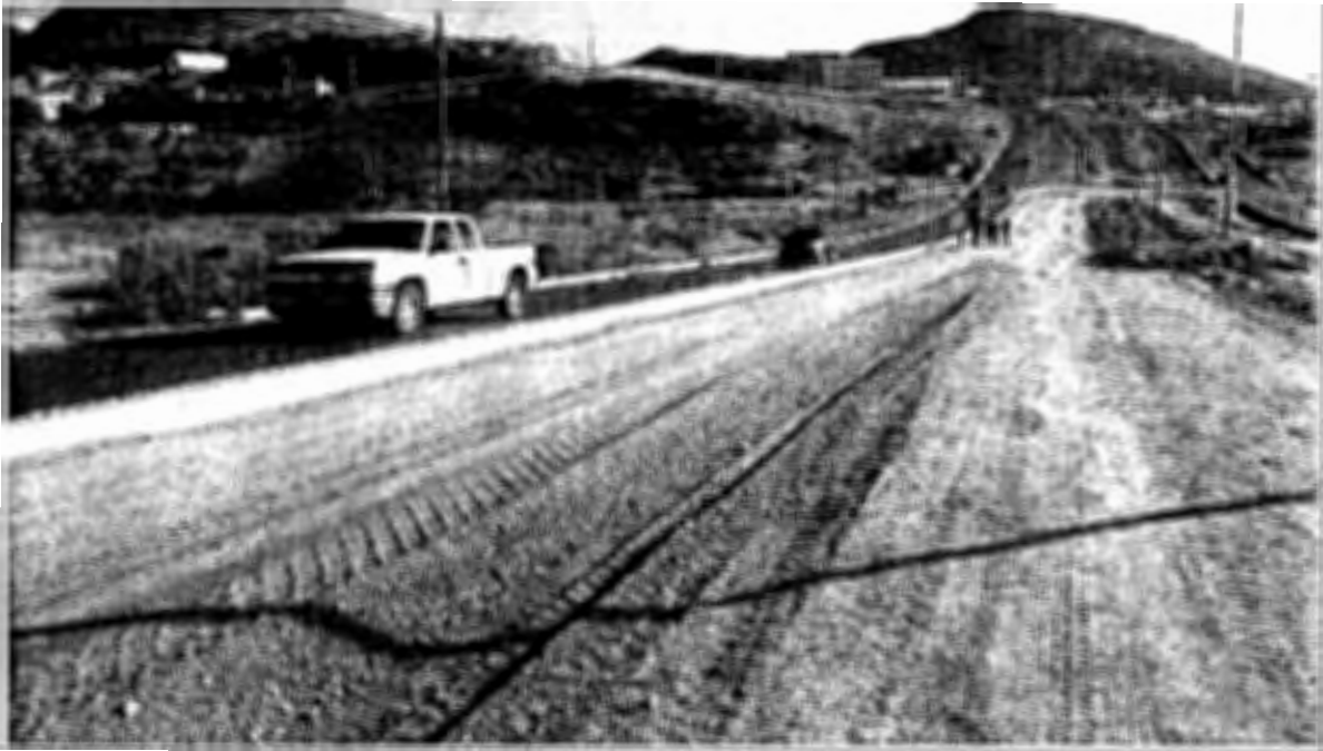
TENDIDO Y TRATADO DE MATERIAL PARA BASE
