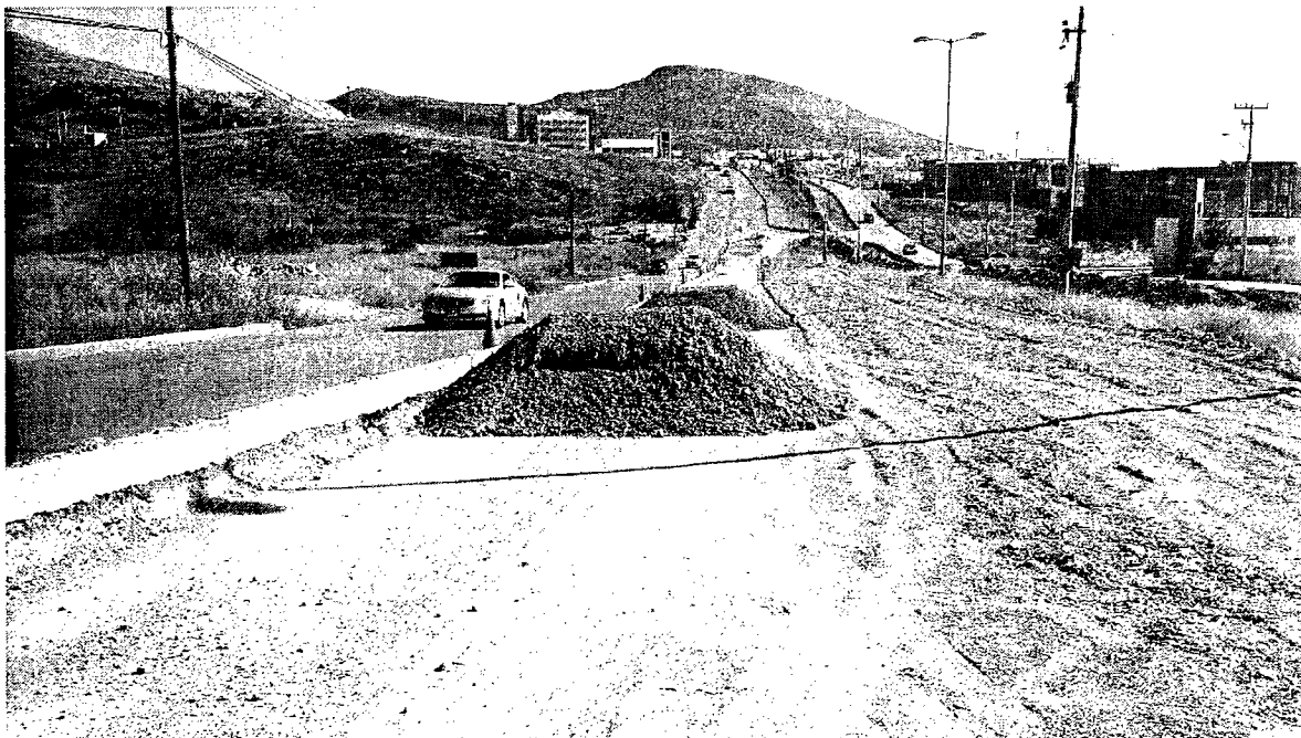
ACARREO DE MATERIAL CALIDAD SUBRASANTE
