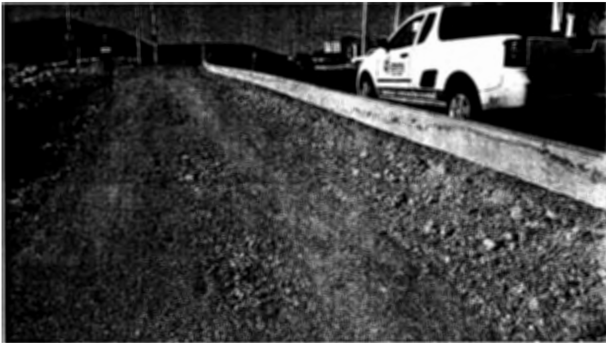
NIVELACION DE TERRENO NATURAL
