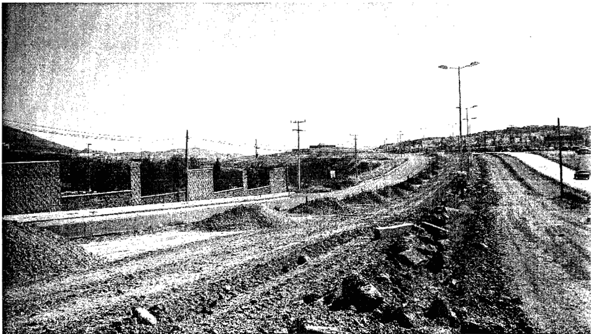
ACARREO DE MATERIAL PARA BASE
