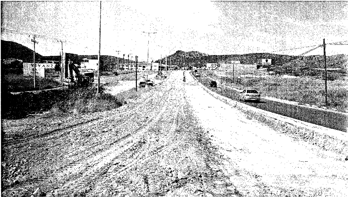
COMPACTACION DE TERRENO NATURAL
