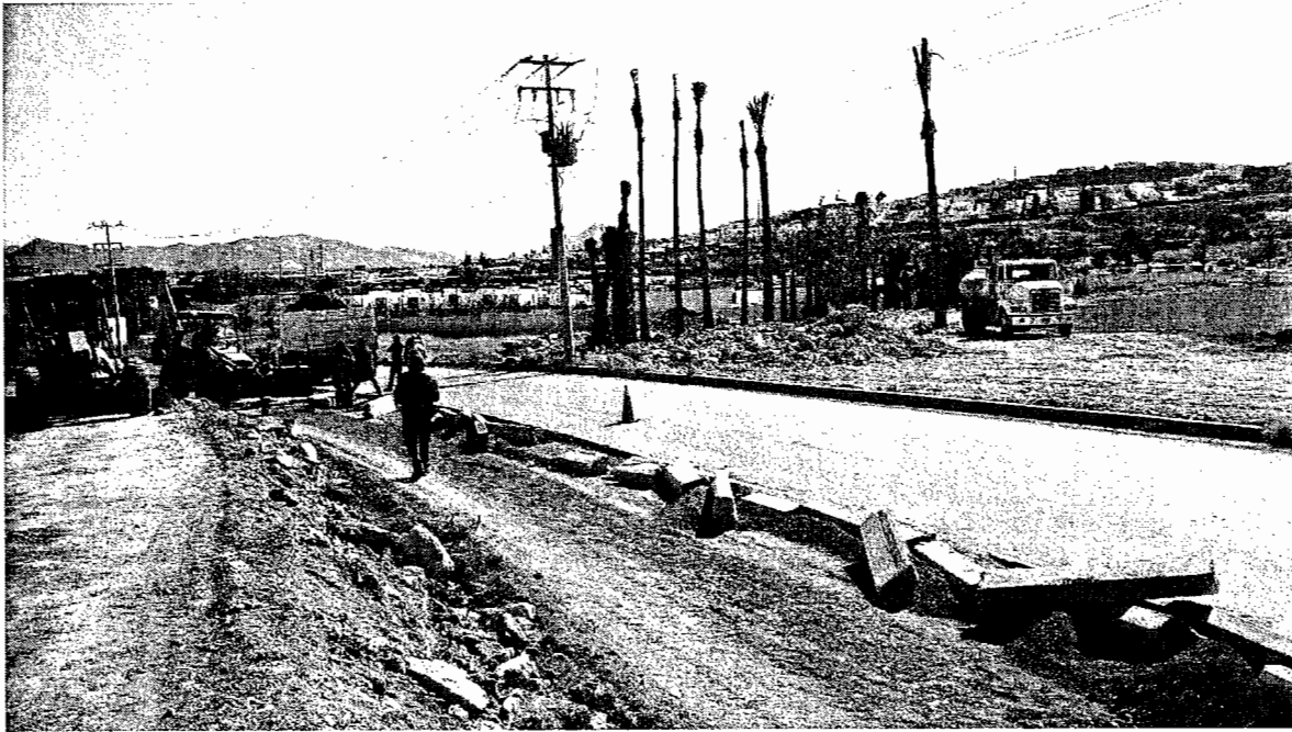
DEMOLICION DE CONCRETO HIDRAULICO
