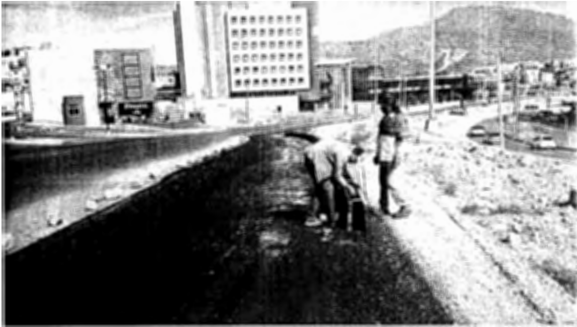
CONSTRUCCION DE GUARNICIONES
