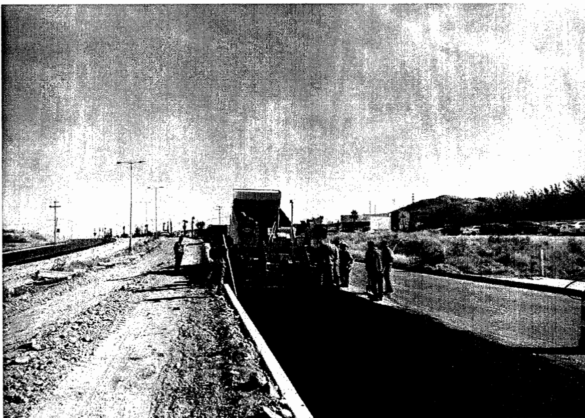
TENDIDO DE CARPETA ASFALTICA
