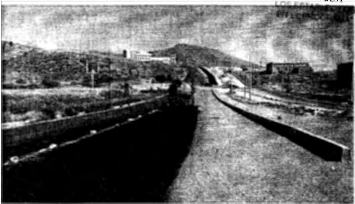
COLOCACION DE RIEGO DE IMPREGNACION
